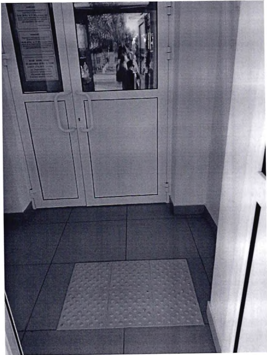
Фото №14 входная площадка перед дверью
